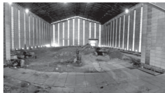
▲工場地上部解体完了状況
