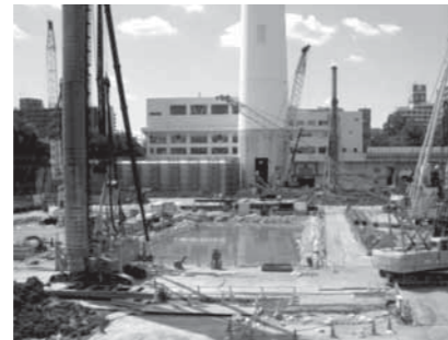
▲SMW工事状況
