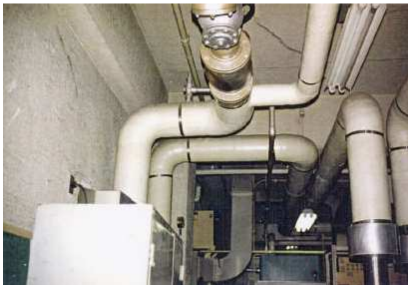
吸音・断熱（機械室 壁・天井）
