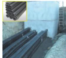
安価で弾性がある角型多条電線管を地下に埋設
