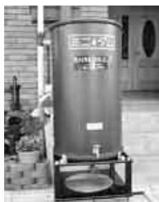
▲小型雨水貯留槽(一例)
