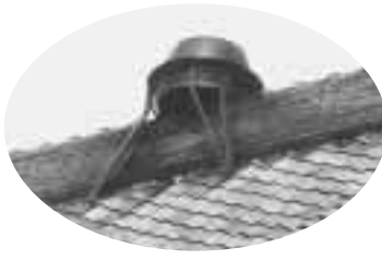
釜寺・本堂の屋根にのっている釜
