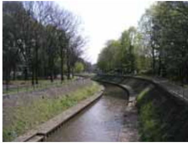
石張りの傾斜護岸 (善福寺川成田上橋付近)
