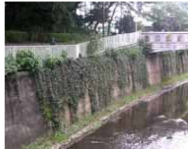
ツタを這わせた護岸 (神田川塚山公園付近)
