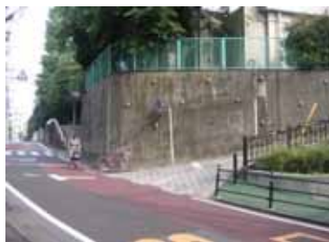
高く垂直のコンクリート擁壁
