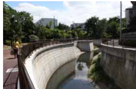
河川と公園を一体的に整備 (神田川と弁天橋東緑地)
