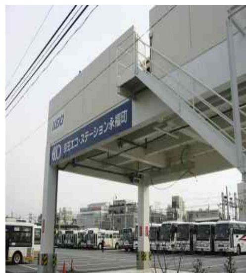
<区内にある天然ガスの供給スタンド>
