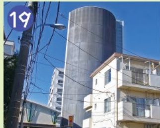
19 井荻トンネルの南換気塔 環八通りは井荻駅を中心に1263mのトンネルとなっていますが、巨大な2本の換気塔が建てられています。
