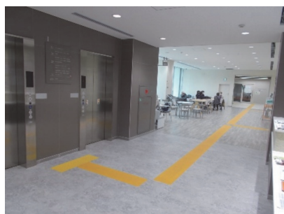
視覚障害者誘導用ブロック (阿佐谷地域区民センター)
