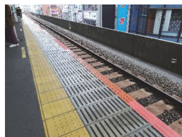
ホームの内方線付き点状ブロック
