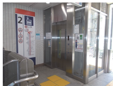
東高円寺駅 新設エレベーター
