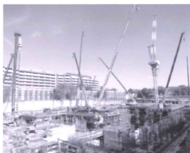
▲11月中旬の工事状況
