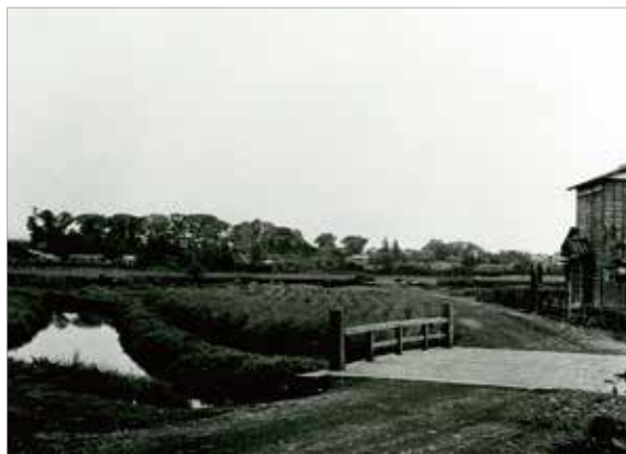
昭和29年当時の善福寺川西田端橋付近(荻窪1・3丁目)
