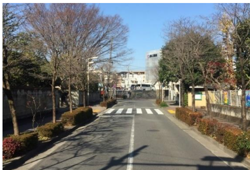
幅員12m事例（和田1丁目付近）
