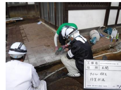
⑧床タイル撤去状況
