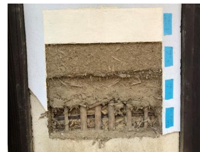
⑦既存壁下地調査状況
