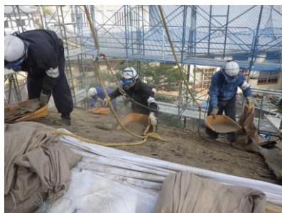
①土葺き撤去状況
