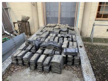
③煉瓦保管状況
