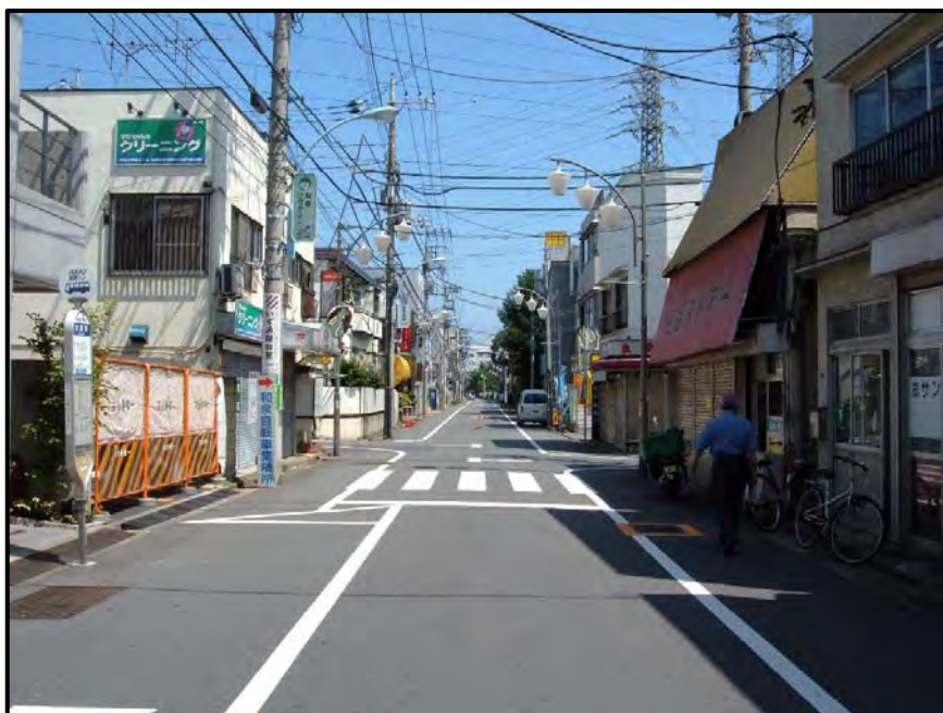
無電柱化整備前
