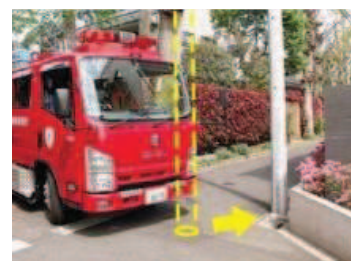
狭あい道路の電柱移設後
