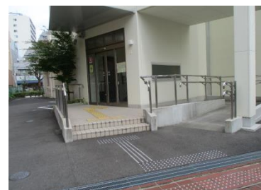
和泉保健センター エレベーターの設置、 グレーチング改修
