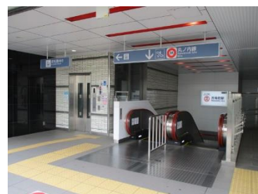
方南町駅 エレベーター・エスカレーターの設置
