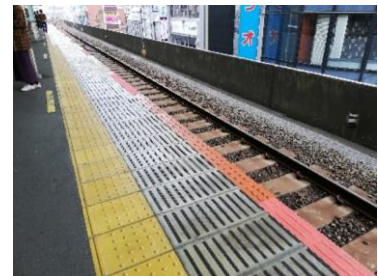
ホームの内方線付き点状ブロック
