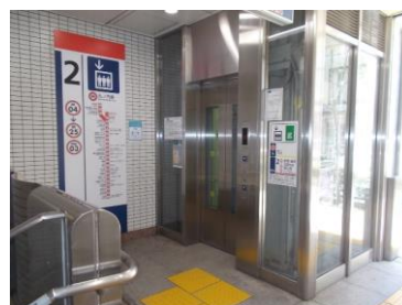
東高円寺駅 新設エレベーター
