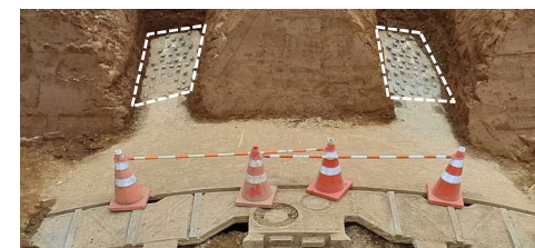
裏込め注入管保護ビット 【裏込め注入材を注入するための管を保護する部材】
