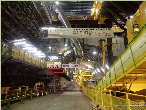
本線南行トンネル立坑
