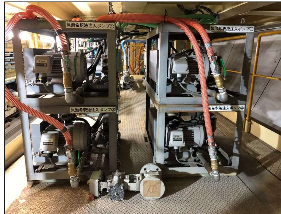
気泡材はマシン後方の後続台車から配管パイプを通してマシンへ注入します
