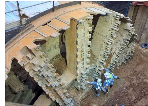
②損傷した部材等の確認
