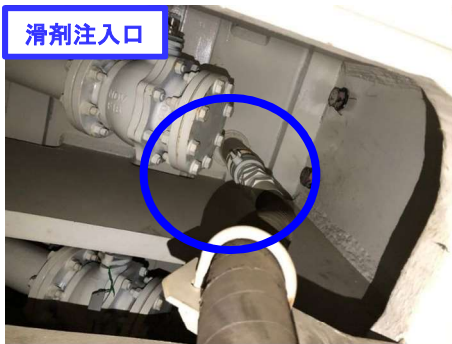
滑剤充填設備(大泉本線(北行)シールドトンネル工事の実績)
