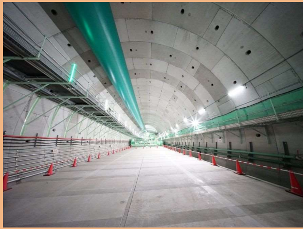
本線北行トンネル坑内
