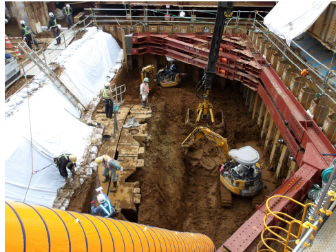
①地上からの開削作業
