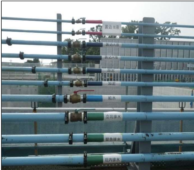
鉍物系添加材は地上から配管パイプを通してマシンへ注入します
