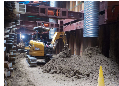
④開削範囲の埋め戻し
