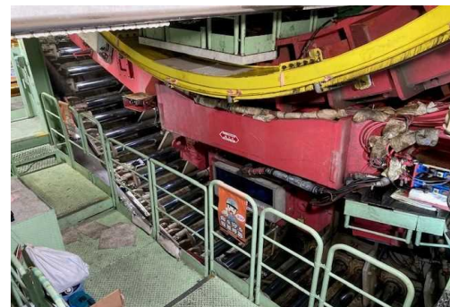
シールドマシンによる掘進状況 (令和5年5月16日)
