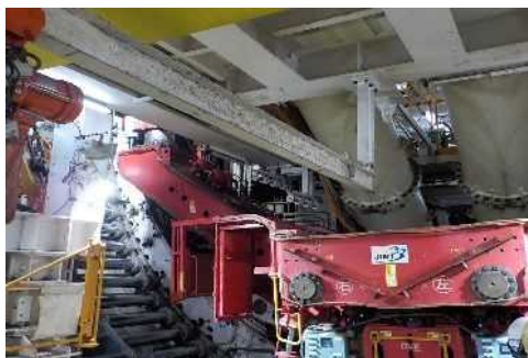
シールドマシンによる掘進状況 (令和5年2月28日)
