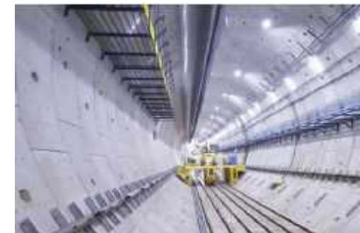
構築されたトンネル内(合成セグメント) (令和2年7月18日)
