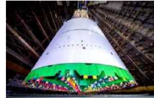
シールドマシン組立状況の前景写真 (平成30年10月25日)
