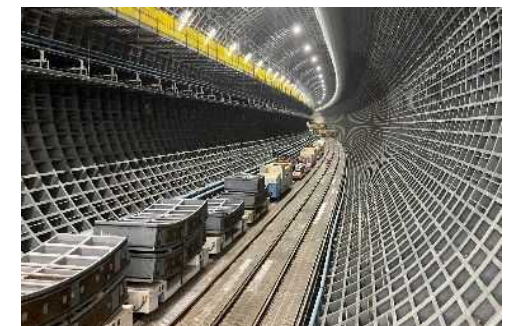
セグメント搬送状況 (令和5年5月22日)
