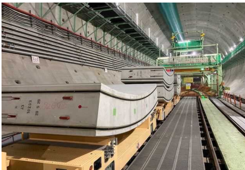
セグメント搬送状況 (令和5年1月19日)
