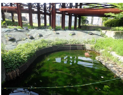
土砂流入防止措置の状況 (R5.4)
