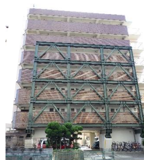
マンションの耐震改修事例
