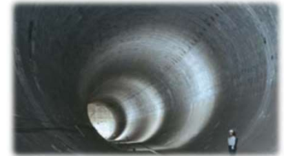
②環状七号線地下広域調節池（石神井川区間） 環状七号線、目白通り（練馬区・中野区） 規模：約681,000m 3
