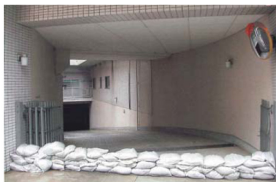
写真 7-2 地下への浸水防止対策の例
