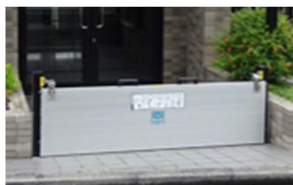
▲防水板の設置事例
