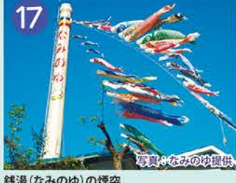
銭湯(なみのの)の煙突 白く塗られたコンクリート製の煙突は、端午の節句頃にはこいのぼりが泳ぎます。クリスマスにはサンタクロースが登るかも。
