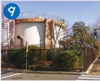
9 水道局貯水槽 上井草スポーツセンター地下の給水池から杉並・練馬に水道水が送られますが、停電時などの衝撃から配管を守るための水槽です。
