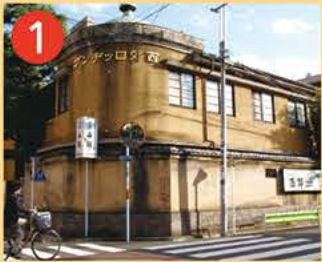
西郊ロッキング 昭和初期に胸付き高級下宿として建てられた建物です。国の登録有形文化財です。
