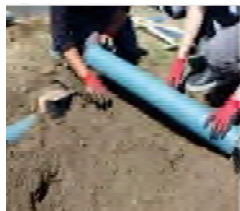
写真 通気透水管の敷設
