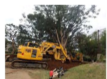
④あらかじめ掘削しておいた植穴におろし、傾きなどを調整
