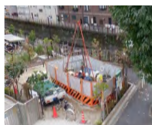
ボーリングにより観測井戸の設置
