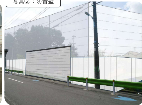
写真②：防音壁
