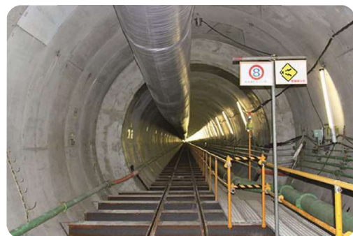
例：地下トンネル内部（施工中）
