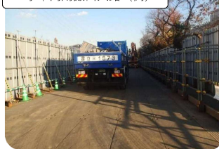
工事車両搬出入路（例）
