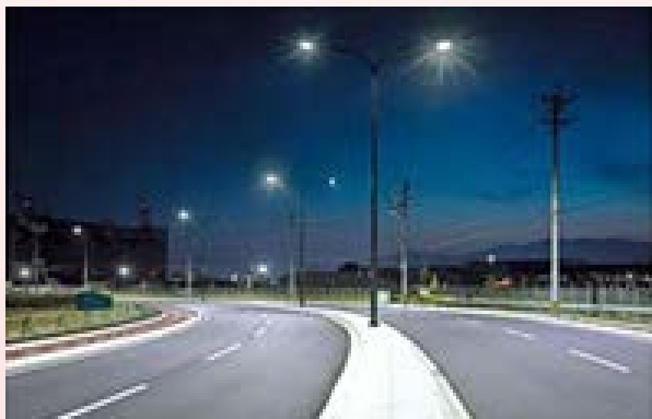
道路照明のLED化
