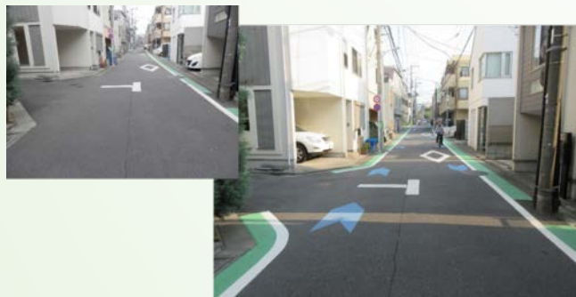
片側から両側への路側帯設置
