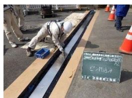
写真3 伸縮装置取替イメージ 平成29年度補修工事写真より抜粋
