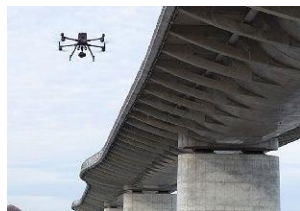
写真4 例：ドローン点検 令和7年4月点検支援技術性能カタログより抜粋
