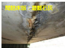
写真2 損傷状況写真 令和5年度 点検調書より抜粋
