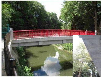
八幡橋（コンクリート橋）
