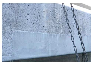
剥落防止工施工前
