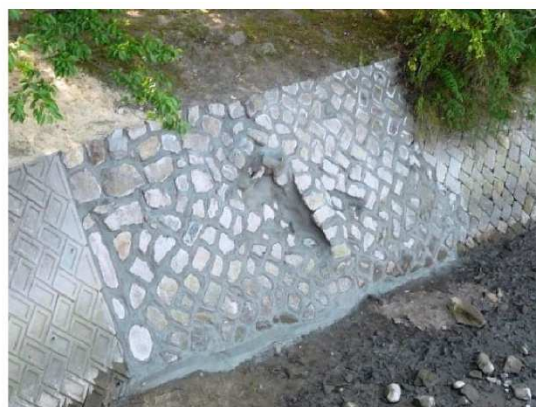
施工後(石積背面の洗掘防止)
