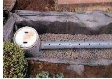
浸透（トレンチ）管
