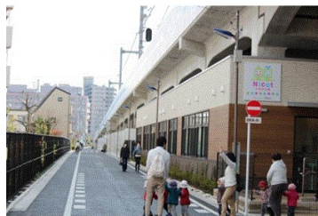
高架下利用事例(保育所)
