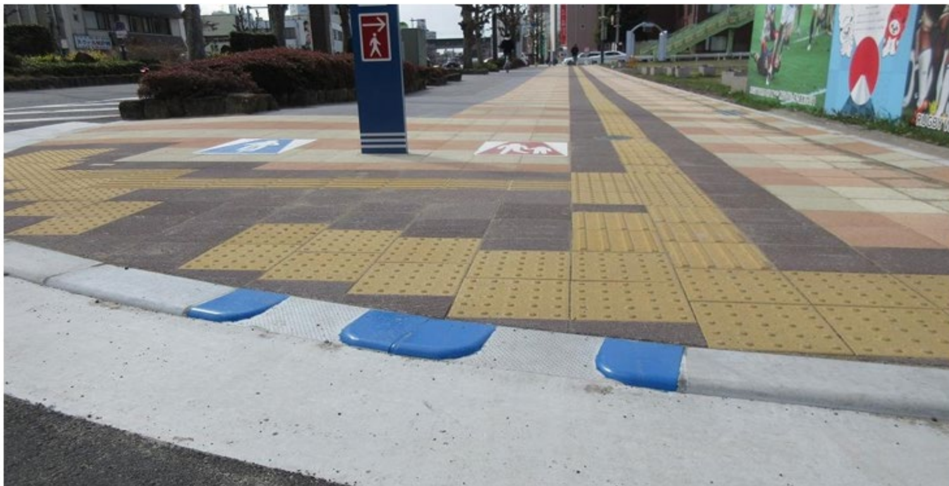
写真 2-1-1 縁端高さ一部 0cm 構造の歩車道境界
