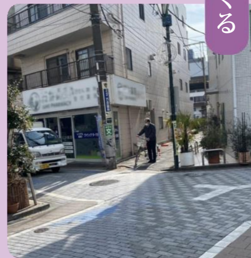
▲自転車侵入防止柵設置による事故防止（新進会商店街通り東側交差点）
