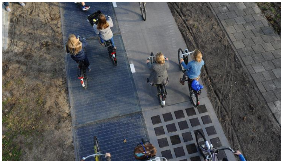
歩道内太陽光タイル
