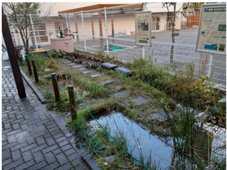
井草地域区民センターに整備した雨庭 (グリーンインフラの一例)
