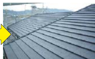
新しい屋根瓦を取り付けて 完成です
