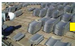
既存屋根瓦を撤去し 下地・防水の補修を行います
