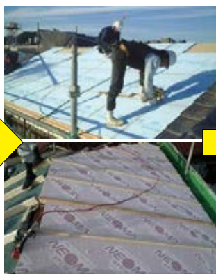
既存下地上に断熱材を施工し 新しい屋根下地・防水層を作ります
