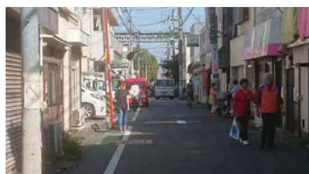
▼現状は幅員が狭く燃えやすい建物が多い (高円寺北)
