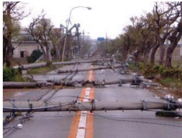
▼電柱の倒壊事例
