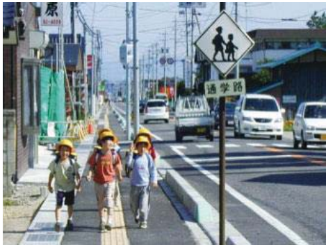
▼歩道設置による安全確保の例
