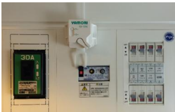
感震ブレーカー設置器具
