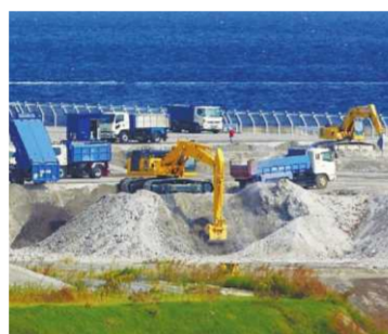
▲灰の埋め立て作業の様子
