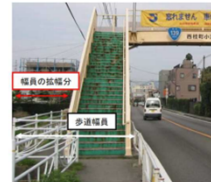
国道139号(山梨県西桂町)
