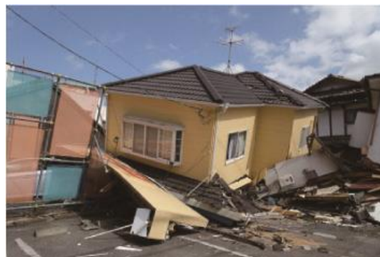
熊本地震被害状況②
