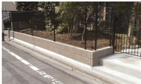
ブロック塀等改修工事後
