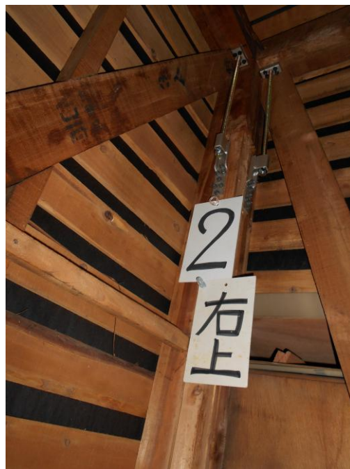
木造住宅の耐震補強例②
