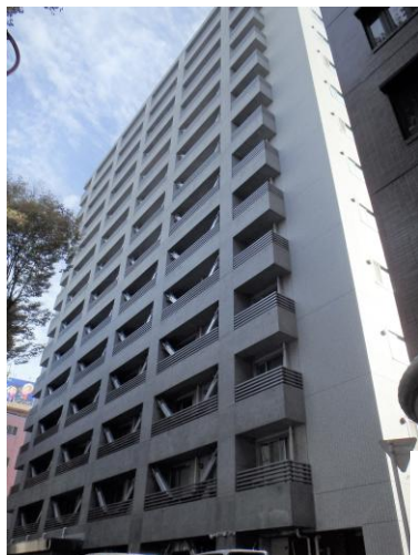
耐震改修工事を行った分譲マンション
