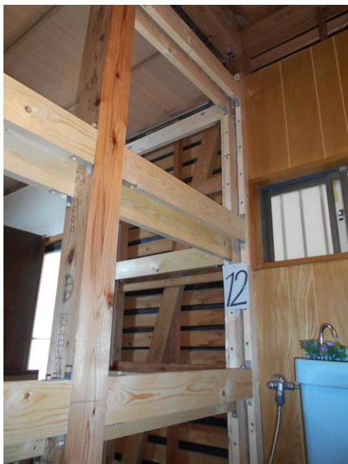
木造住宅の耐震補強例①
