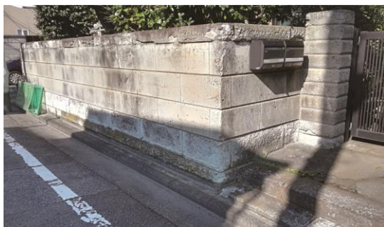
ブロック塀等改修工事前
