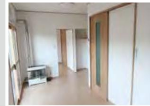
②段差解消(居間・洋室)
