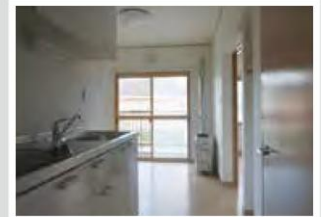
⑥防音サッシ設置(居間)
