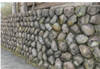
空石積み擁壁
