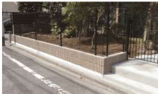
ブロック塀等改修工事後
