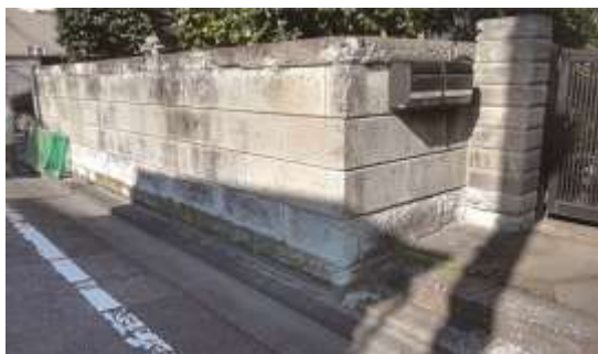
ブロック塀等改修工事前
