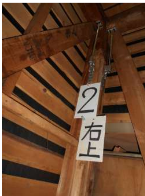
木造住宅の耐震補強例②
