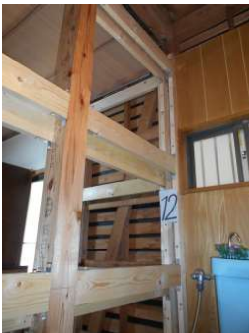
木造住宅の耐震補強例①
